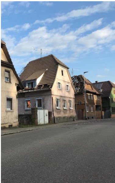
Bei Beginn der Abbrucharbeiten
