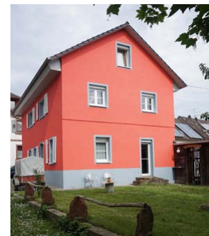
Ansicht von West
