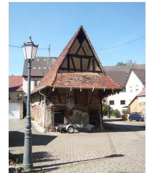
Scheune von Süden
