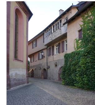
Südseite von der Kirchstraße aus
