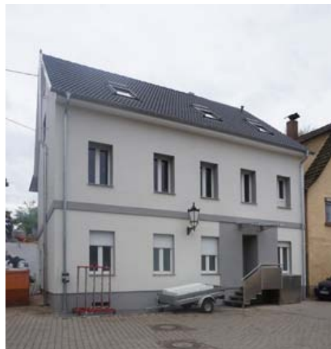
Zustand nach der Sanierung
