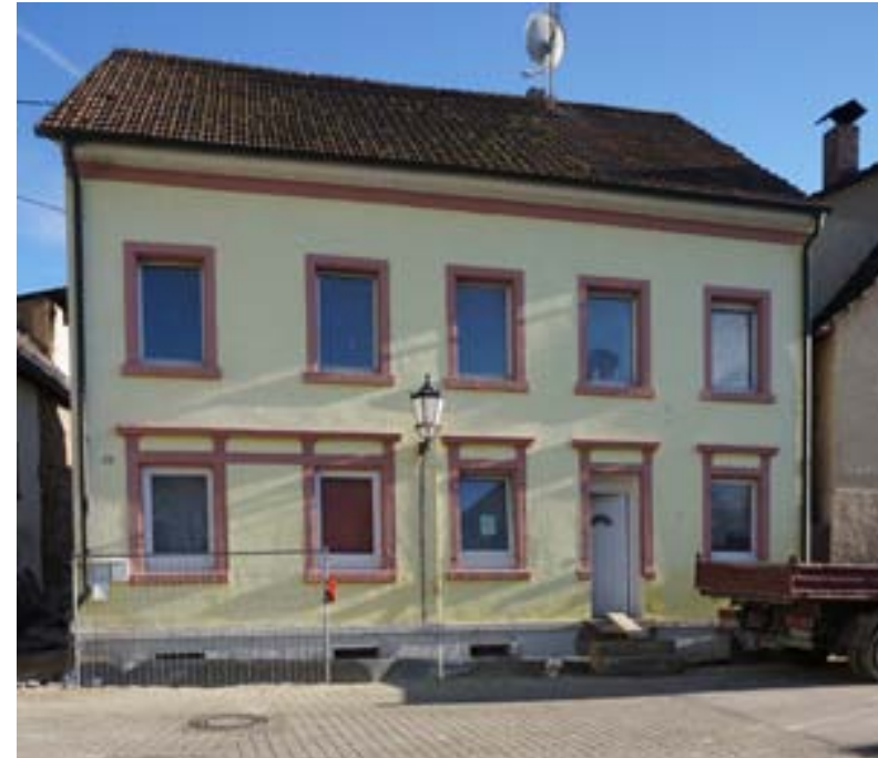
Zustand vor der Sanierung, Nordansicht
