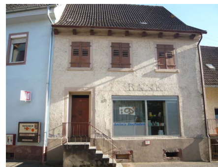
Ansicht von West
