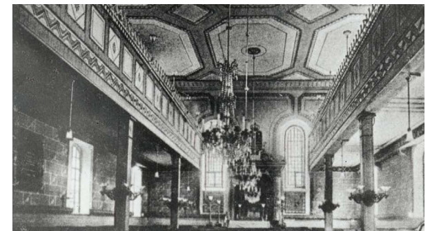
Historische Aufnahme, Innenraum
