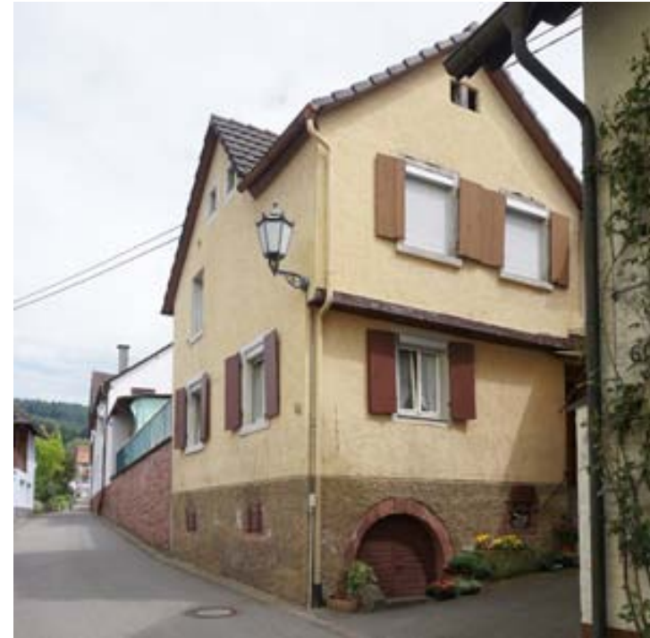
Ansicht von Westen
