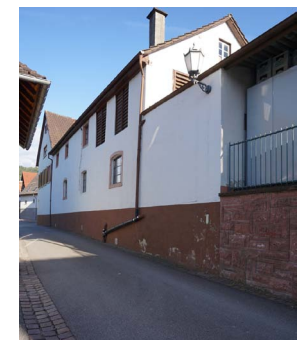
Ansicht von Osten
