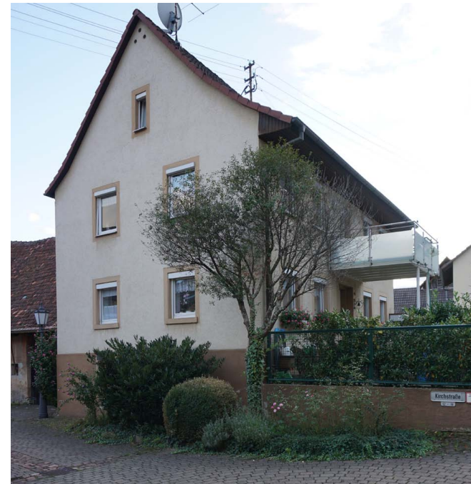
Ansicht von Osten
