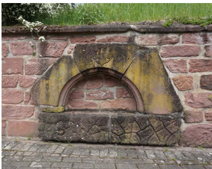
Spolie im westlichen Teil der Anlage
