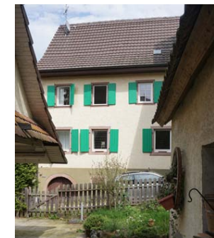
Ansicht von Westen
