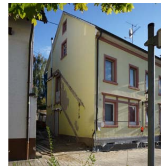
Spuren der ehem. Treppe
