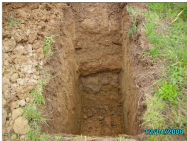
Abb. 7 aufgeschlossene Lockergesteinsdecke im Bereich von Schurf 1
