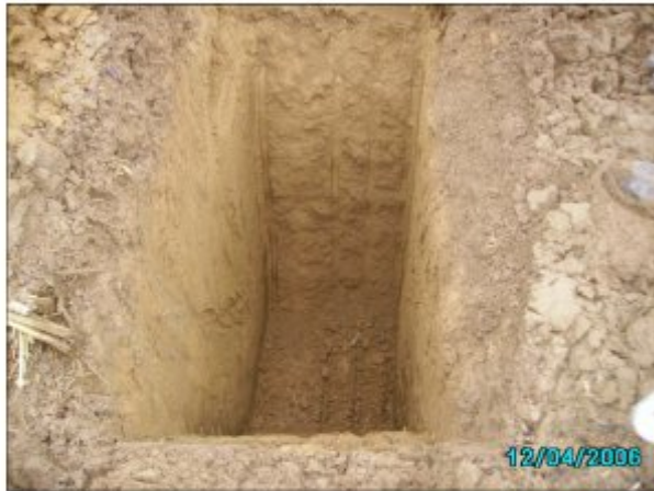
Abb. 3 Erkundungsschurf zum Versickerungsversuch VV 1
